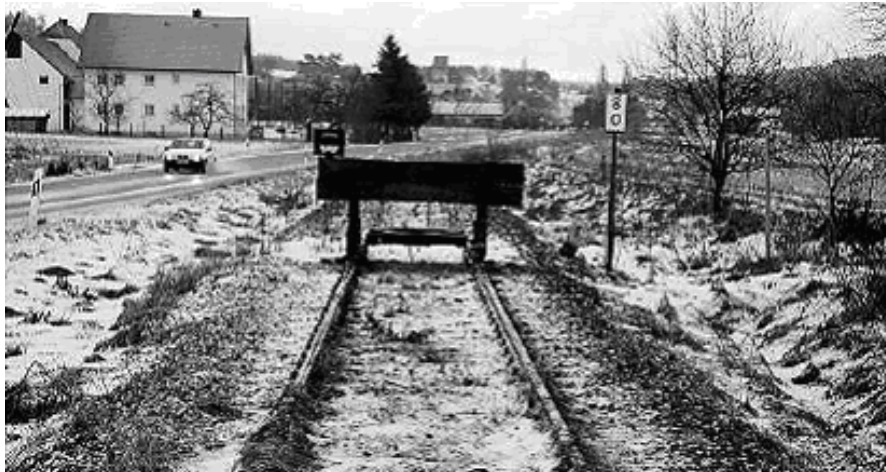
Ab hier Rammbock „Am Wiesengrund“ würde der Radweg beginnen wenn
